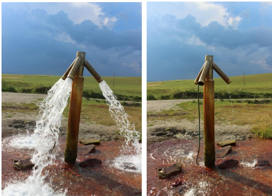
21. ábra: A baloldali kép a Gyergyóremetei-fúrás erupcióját, a jobboldali az erupciók közötti szünetelési állapotot mutatják.
