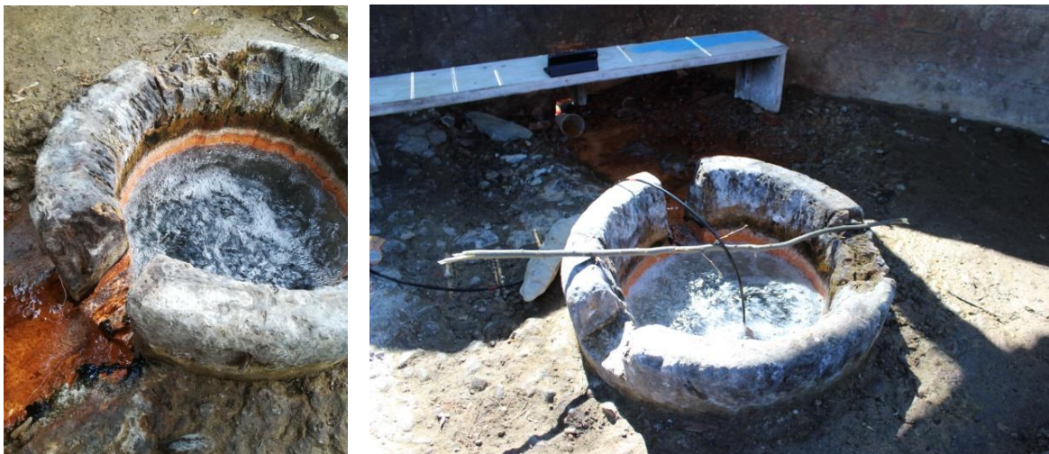
22. ábra Baloldalt a Rákospataki ásványvíz-forrás betonfoglatán való átfolyása, a jobboldali képen a forrás egy alacsonyabb szintje látható.
